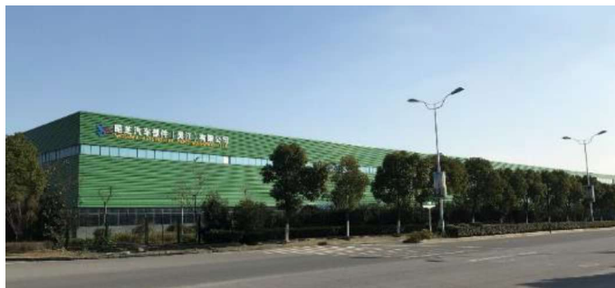
【呉江工場外観】
